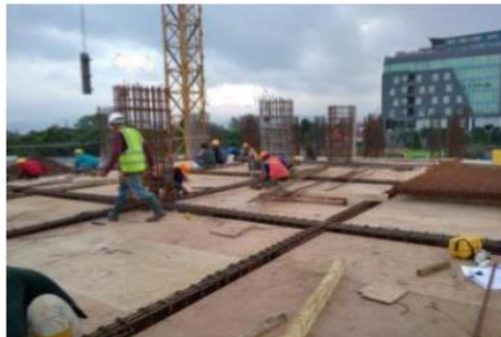
Gambar 6. pemasangan bekisting pelat
