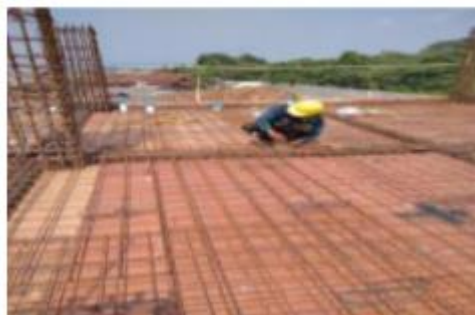
Gambar 7. mengikat pelat lantai dengan balok
